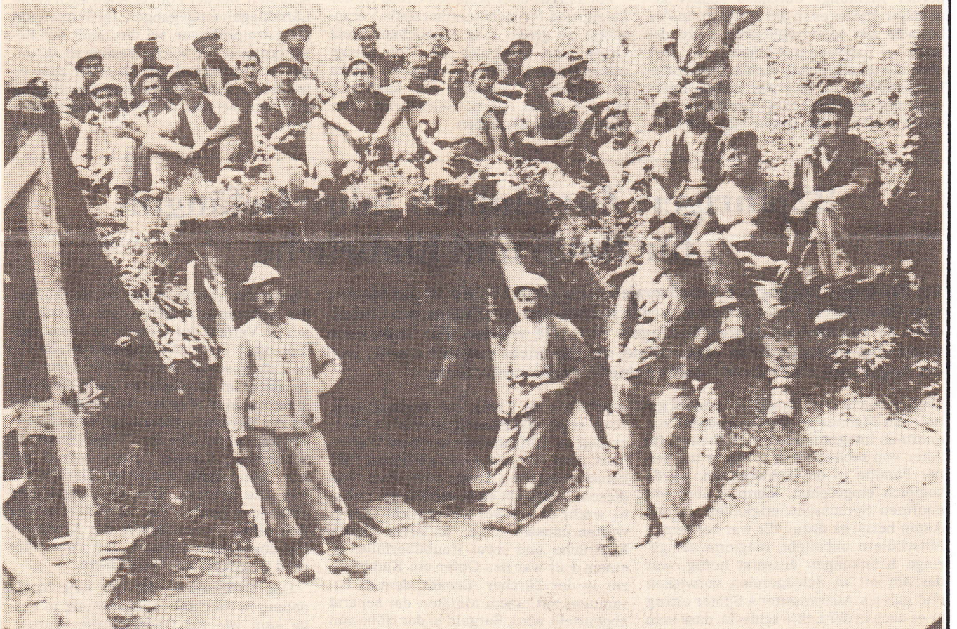
Vor dem Stolleneingang im Aegustertal. Von hier wurde die Kohle einst mit Holzvergaser-Fahrzeugen zum Bahnhof Affoltern gebracht. (Bilder PD)
